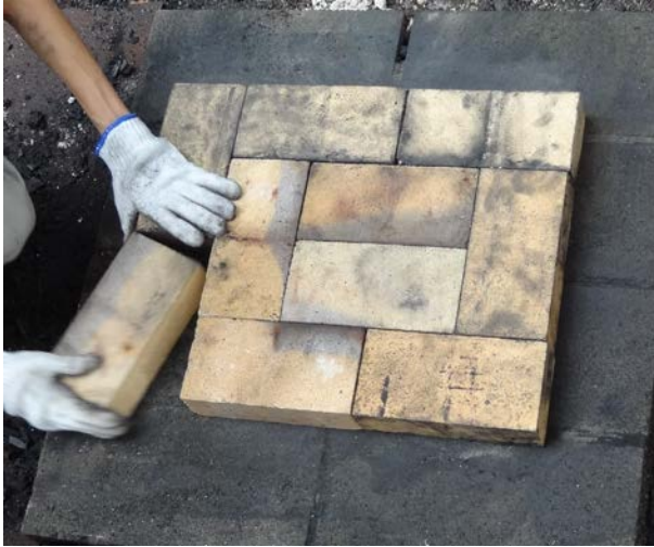
図 6-1. たたら炉の土台づくり。1段につき 10 個の煉瓦を並べてつくる。
