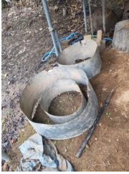
①外部用の型枠
