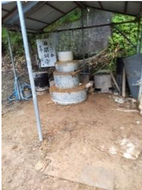
④型枠に赤土を入れ固める
