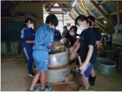
④型枠に赤土を入れ固める
