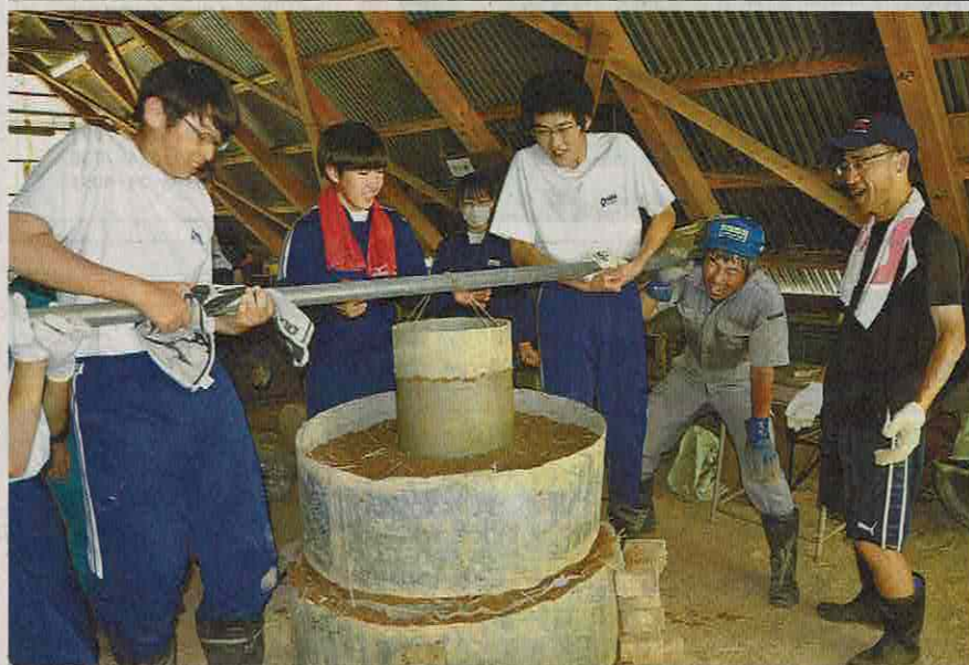
たたら製鉄に用いる炉造りの作業を進める大東中の生徒たち
